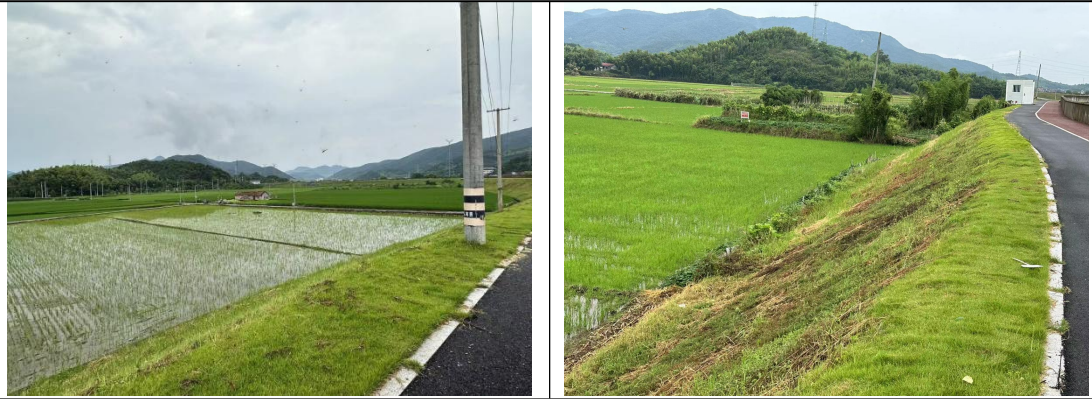
两侧堤坝生态恢复情况
