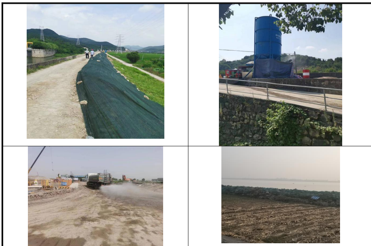
图6-1施工期现场照片
